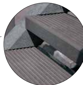
Particolare degli scalini
