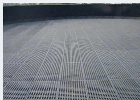
La stabilità della struttura dopo 48 ore con un carico di 60 ton/m 2
